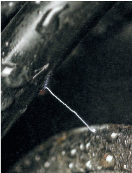
Straumen går minste motstands veg. Er det dårleg kontakt på pluggen kan høgspenten like godt hoppe til bensinpumpa om den er nærme nok.
