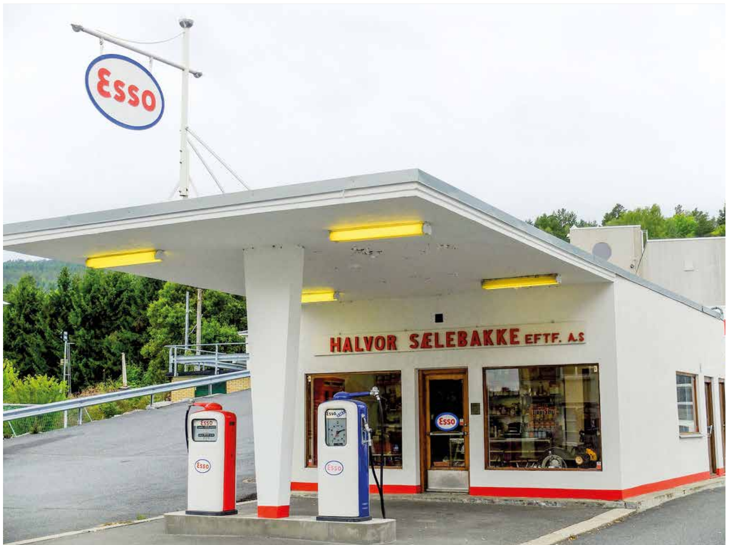
Kongsbergs eldste bensinstasjon etter Halvor Sælebakkes eftf., perfekt restaurert tilbake til original 1953 utgave av Bjørn Thomas Hoen. Kongsberg kommune har delt ut restaureringspris for den fine oppussingen av bensinstasjonen.
